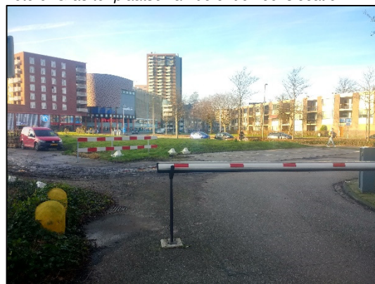
Foto 8: Afsluiting oostelijk deel rijbaan
