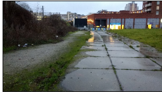
Foto 2: Stelconplaten en halfverharding.
