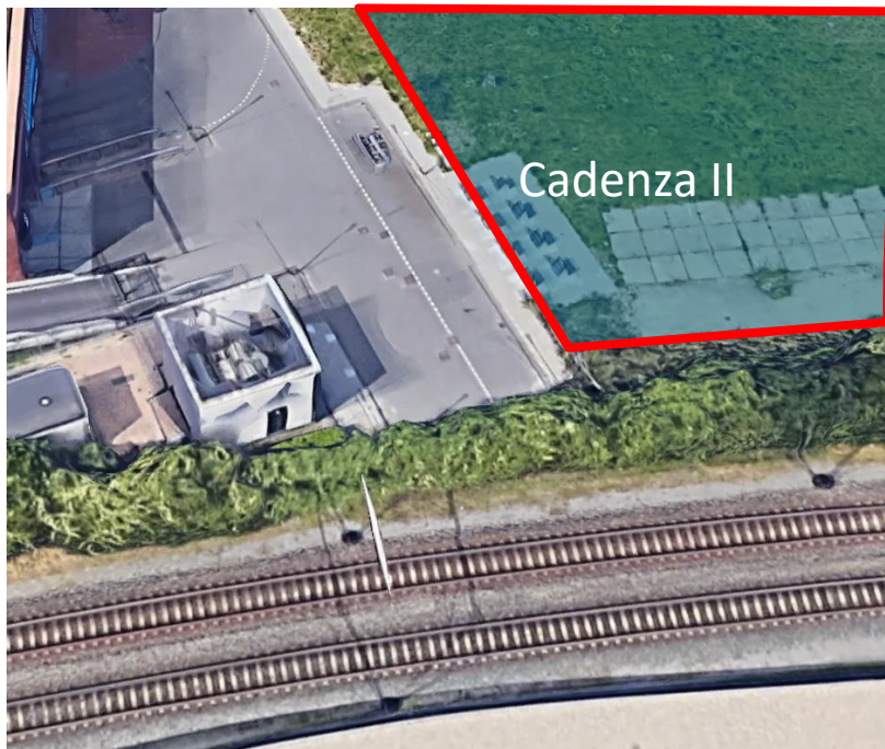
Afbeelding 1.1 Situering van het transformatorstation ten opzichte van de beoogde nieuwbouwlocatie
