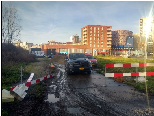
Foto 3: Stelconplaten en halfverharding.
