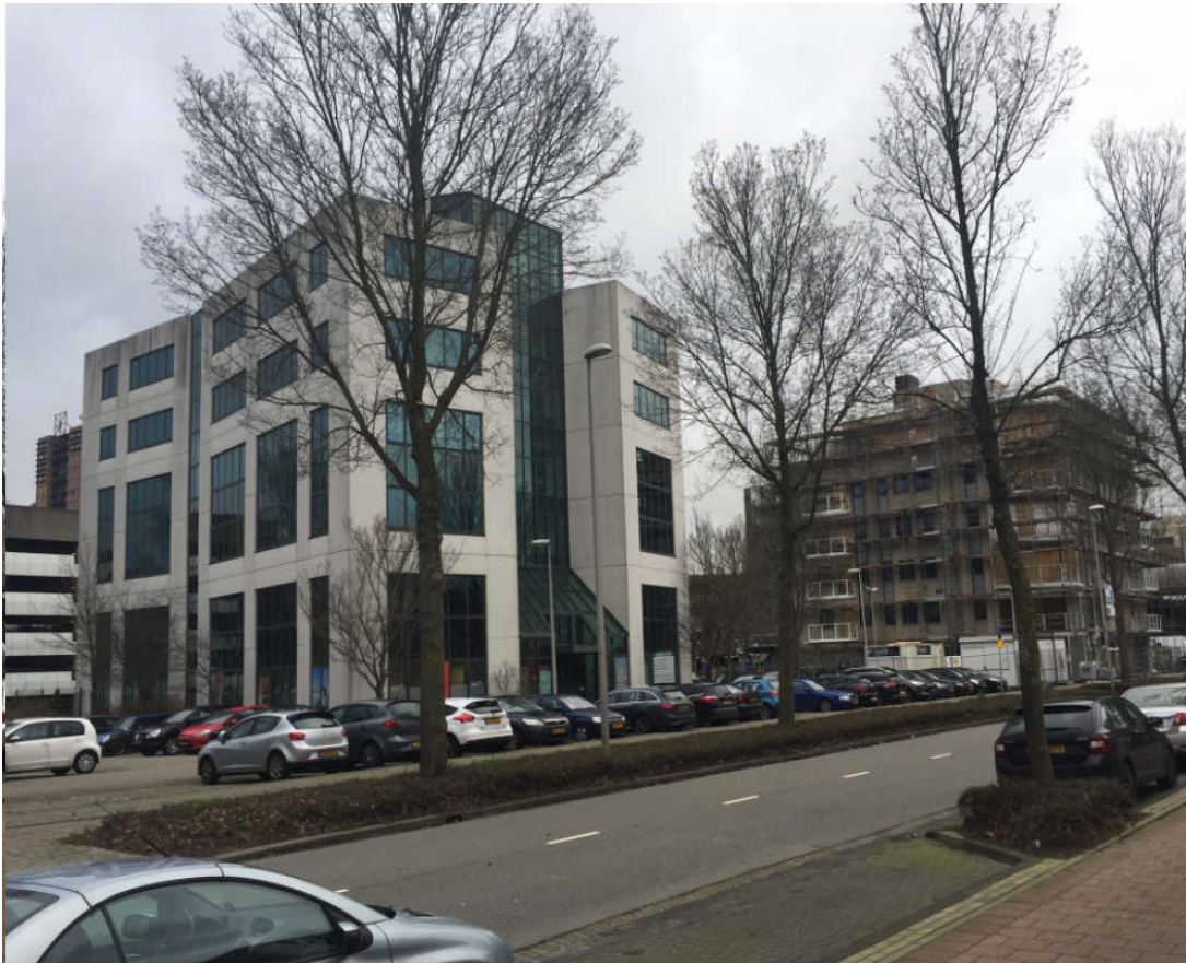
Figuur 2.1 Plangebied gezien vanuit het zuiden (Engelandlaan) met parkeren om het gebouw heen
