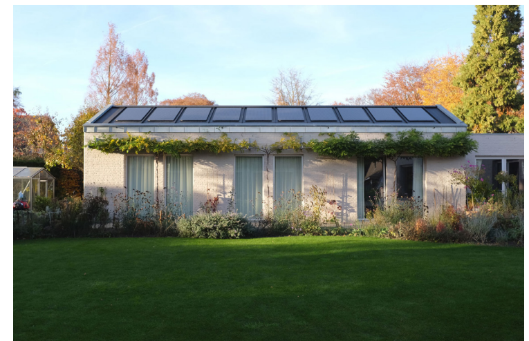
Energie neutrale slaappleugel van de gelijkvloerse hofwoning in Vlijmen
