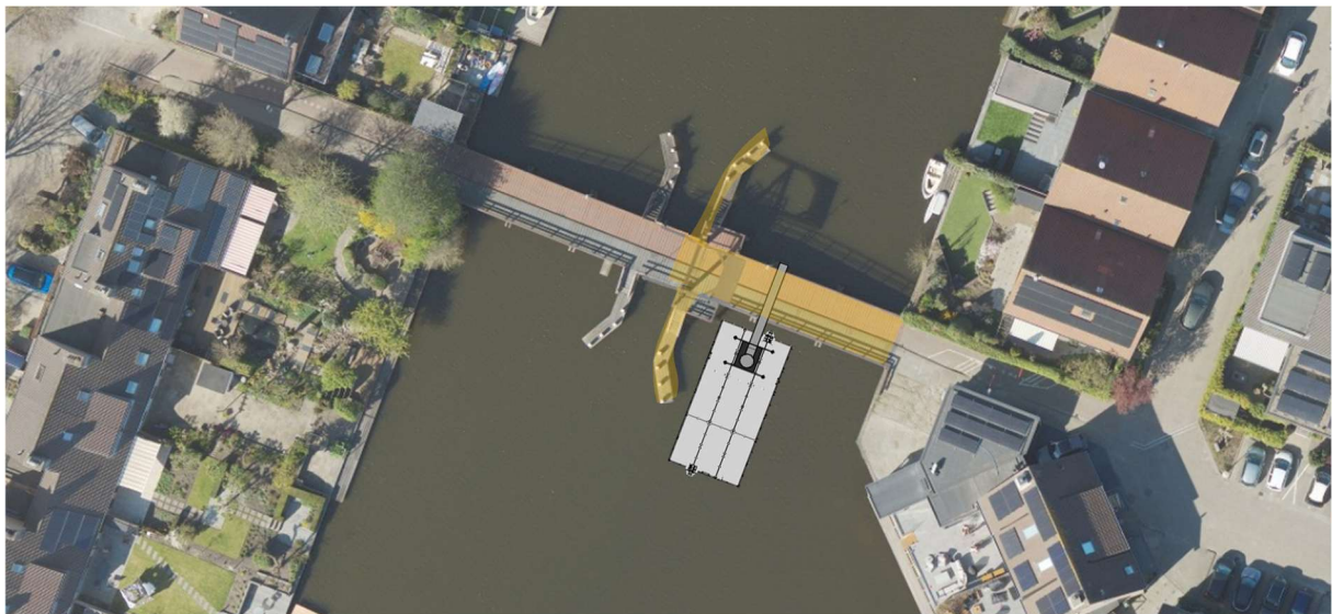
Figuur 10: Aanbrengen van de nieuwe stalen kespens (Fase 4.2)
