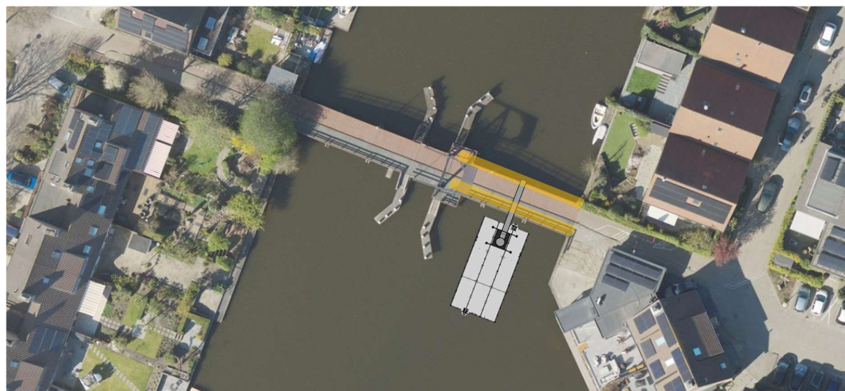
Figuur 16: Aanbrengen van het nieuwe stalen leuningwerk (Fase 7.2)
