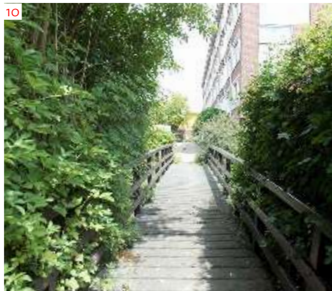
10 Brug verbinding aan noordzijde.
