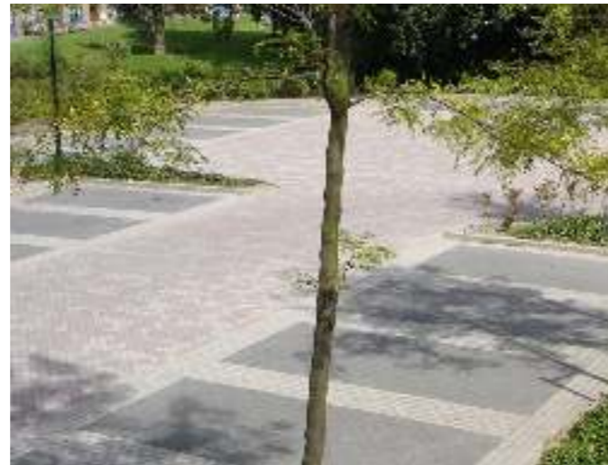
Parkeren: grijze betonklinkers in elleboogverband.
