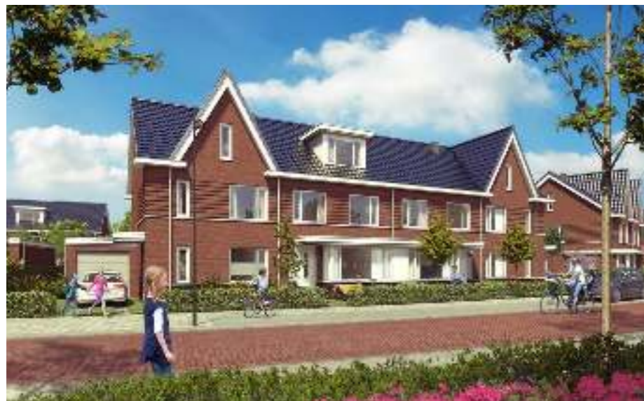
Dwarskappen aan het einde van elk bouwblok.
