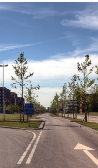
Asfalt en Grasklinkers
