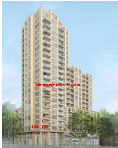
Figuur 7 Hoogte balustrade om te voldoen aan de eis van een luwe buitenruimte
