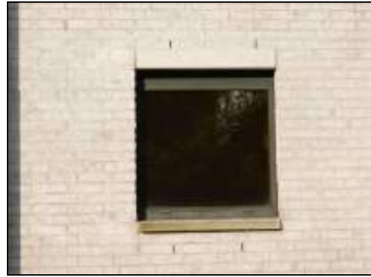
Afbeelding 4 & 5: Ruimte onder daklijst en open stootvoegen onder de dakrand en boven en onder de ramen.
