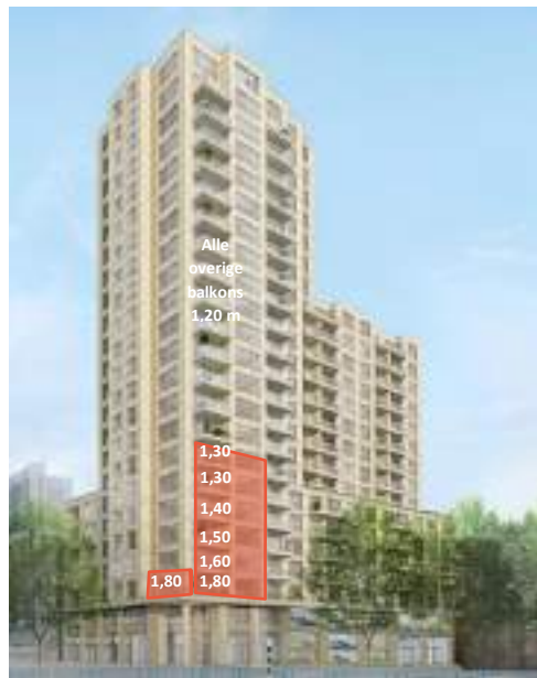
Figuur 10 Hoogte balustrade om luwe geveldelen te realiseren
