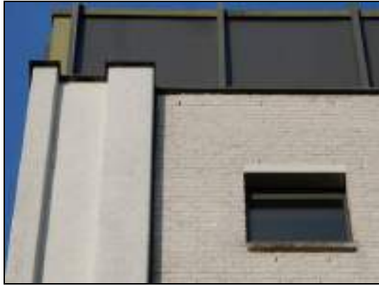
Afbeelding 4 & 5: Ruimte onder daklijst en open stootvoegen onder de dakrand en boven en onder de ramen.
