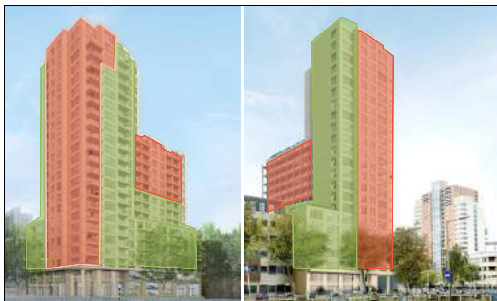
Figuur 4 Locaties waar (zonder maatregelen) niet wordt voldaan aan het beleid ■ Geen geluidsluwe buitenruimte en geen geluidsluwe gevel (36 woningen) ■ Geen geluidsluwe buitenruimte (98 woningen)
