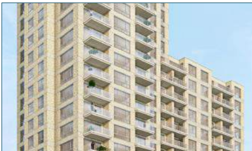
Figuur 5 Balustrades bij 70LUX – 1,20 meter hoog
