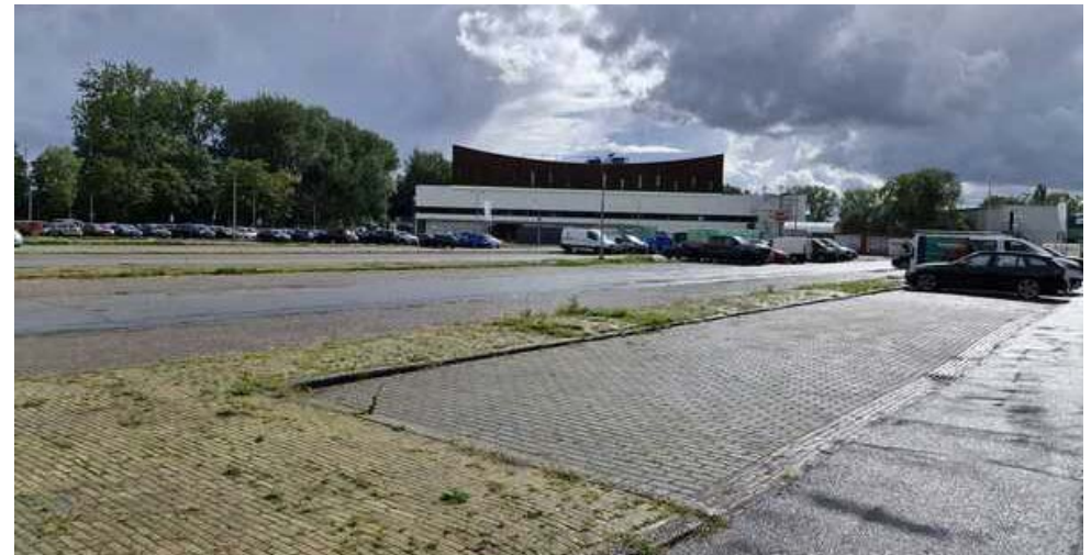
Huidige parkeerterrein Van Tuylpark met op de achtergrond Sweet Lake Wellness in aanbouw.
