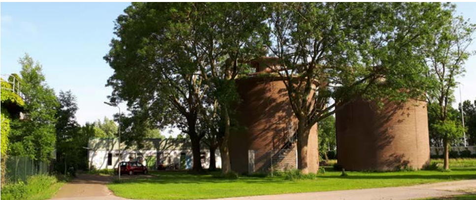
Voormalige waterzuivering op Rokkehage
