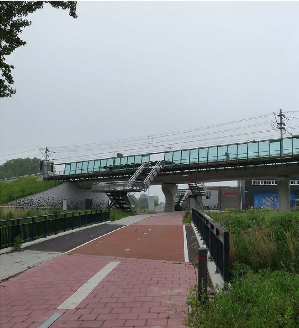
RandstadRailhalte Van Tuylpark
