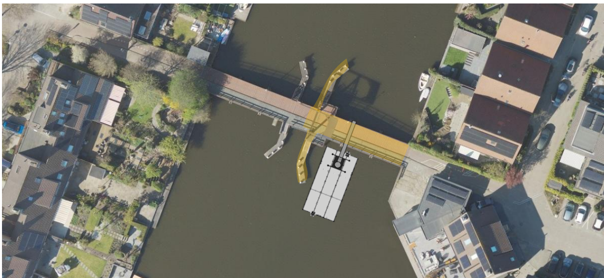
Figuur 11: Aanbrengen van de nieuwe stalen langsliggers (Fase 5.2)
