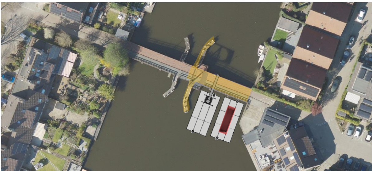
Figuur 7: Deelvervangning van de meerpalen (Fase 3.2)
