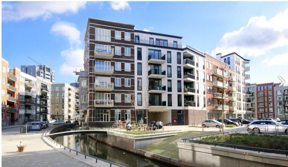
Referentie: Hollandpark Blok 5 Diemen (Bron: Mulleners en Mulleners)
