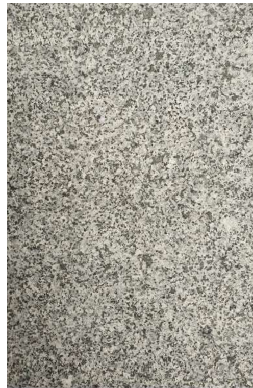
Bies langs gevel, Granieten band 350x200x80 en 150x200x80 mm, type Blue Oriënt NEW (83-N), zichtzijde gevlamd overige zijden gezaagd
