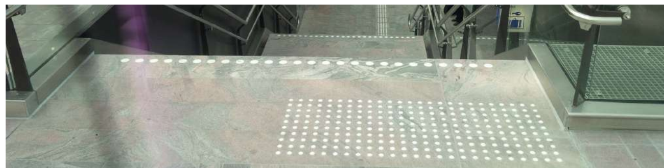
Twee componenten kunsthars op gevlamd graniet (Rotterdam Centraal)
