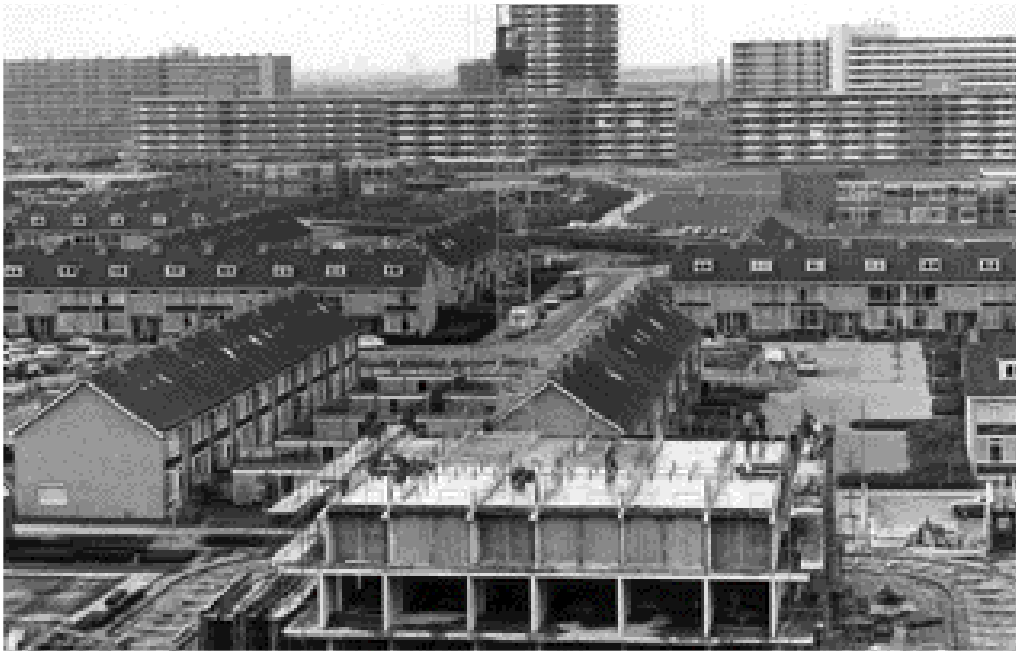
De bouw van een van de zes woontorens (Annaplaats, 1973). Laag voor laag werden zij volgens de gietbouwmethode opgetrokken. Foto Gemeentearchief Zoetermeer.
