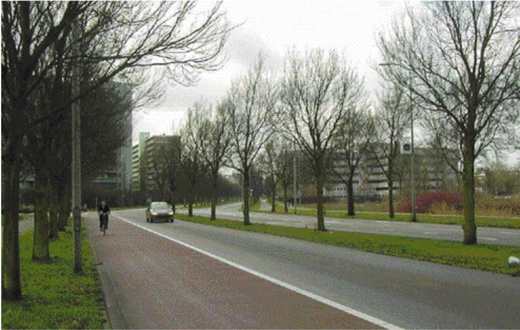
De Boerhaavelaan aan de westkant van Driemanspolder fungeert als wijkontsluitingsweg en scheidt tevens de kantorenstrook (rechts) van het woongebied.
