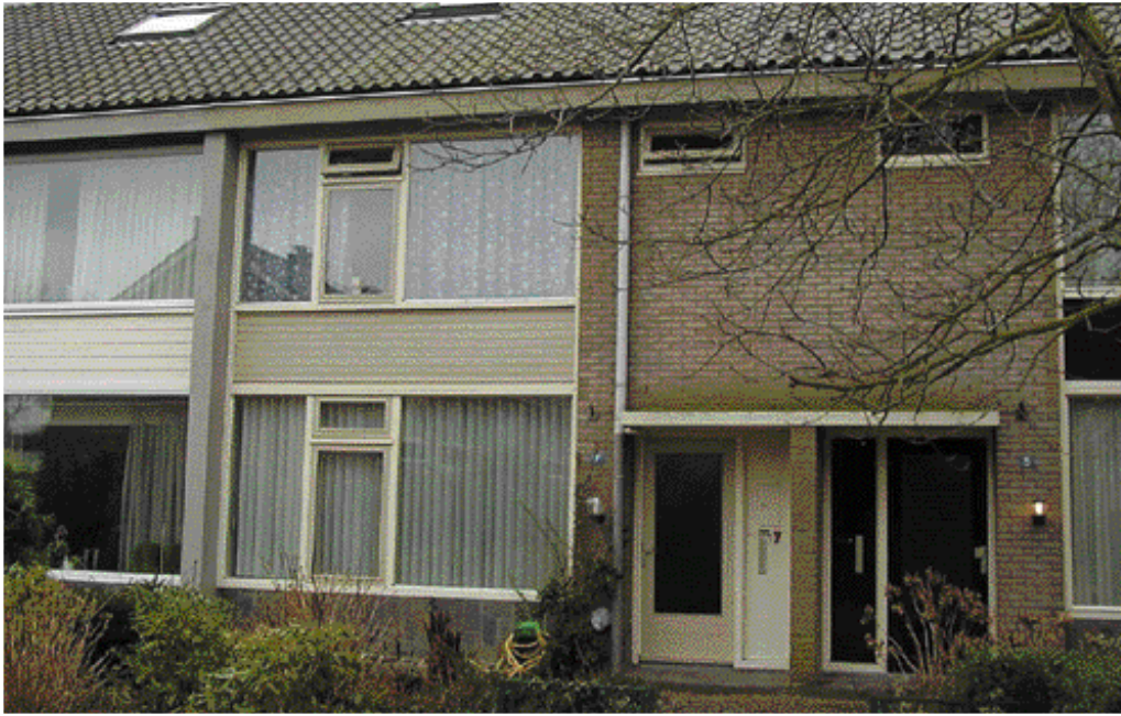
Hoewel standaardbouw, is bij de BOB-woningen aandacht besteed aan kleine details in de voorgevel zoals een borstwering van breuksteen onder het raam op de begane grond.
