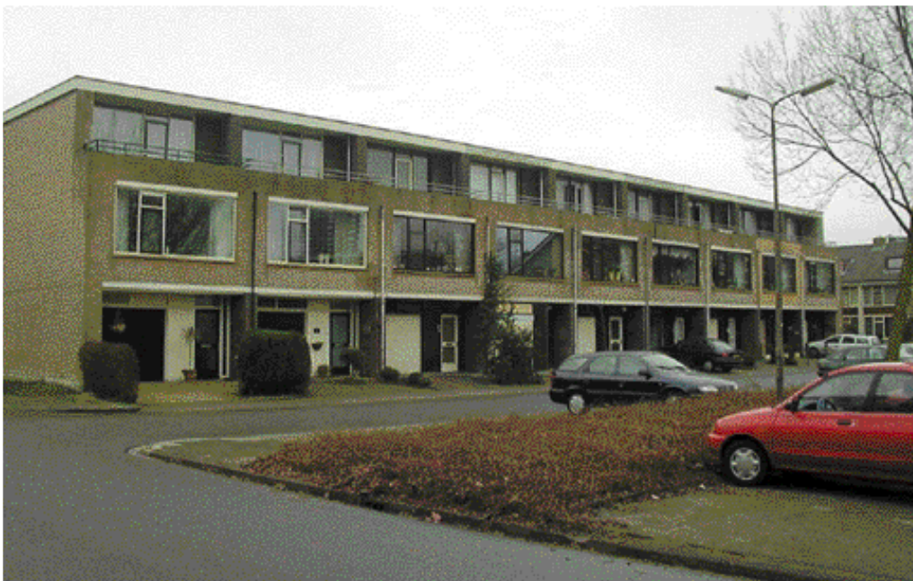
Drive-in woningen van architectenbureau Tol, Noordhoek en De Ruyter met terugliggende derde laag.
