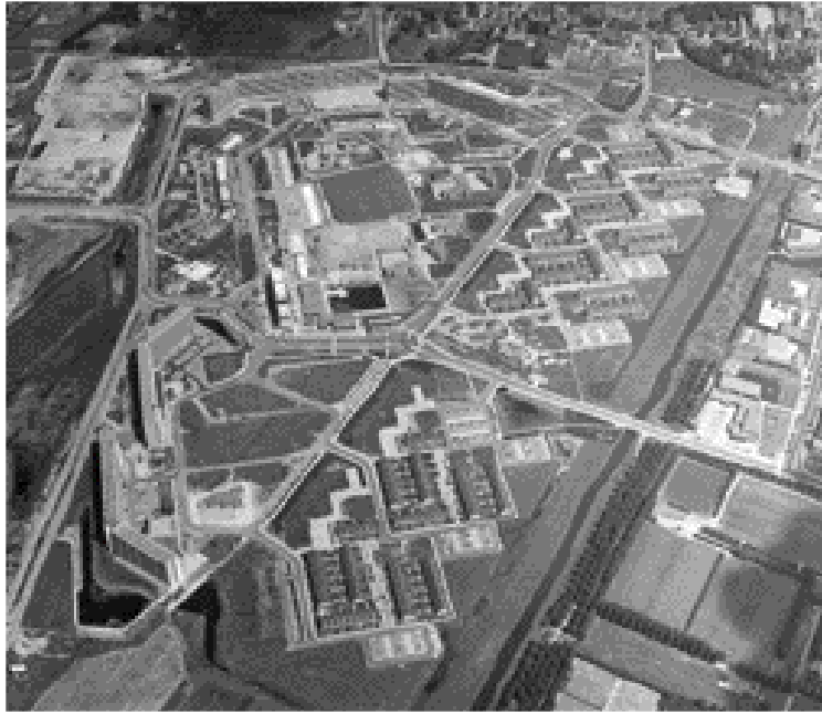
In 1971 was de bouw van Driemanspolder al een eindje gevorderd. Duidelijk te zien zijn het scherm van flats langs de ringwegen en de laagbouw langs de Delfsewallenwetering. Foto Gemeentearchief Zoetermeer.
