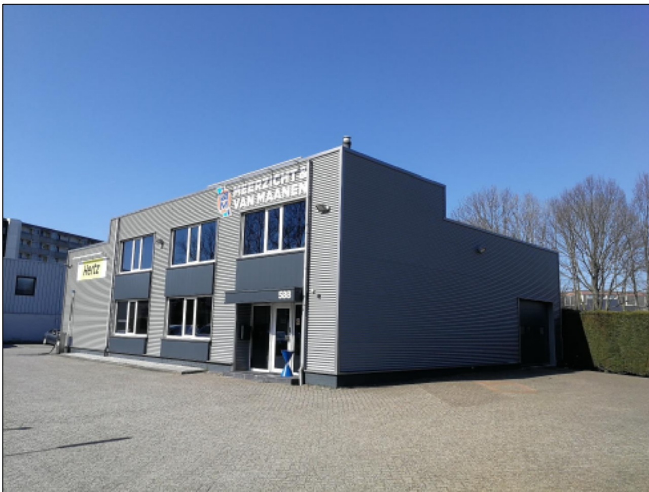
Figuur 2. Zicht op locatie aan de oostzijde, met een van golfplaat opgetrokken bouwwerk zonder noemenswaardige ecologische potenties.
