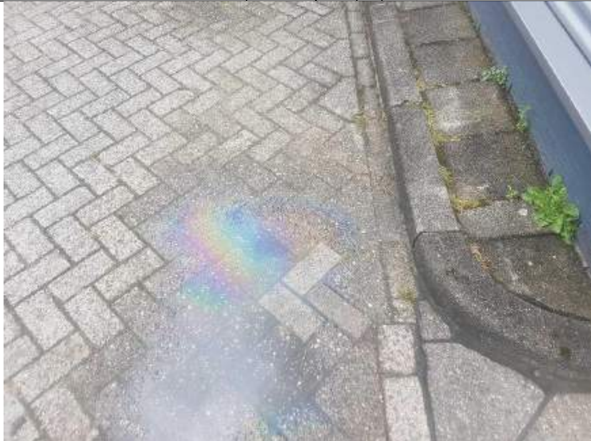
Foto 20. Oliefilm op water nabij dieselpomp en wasloods
