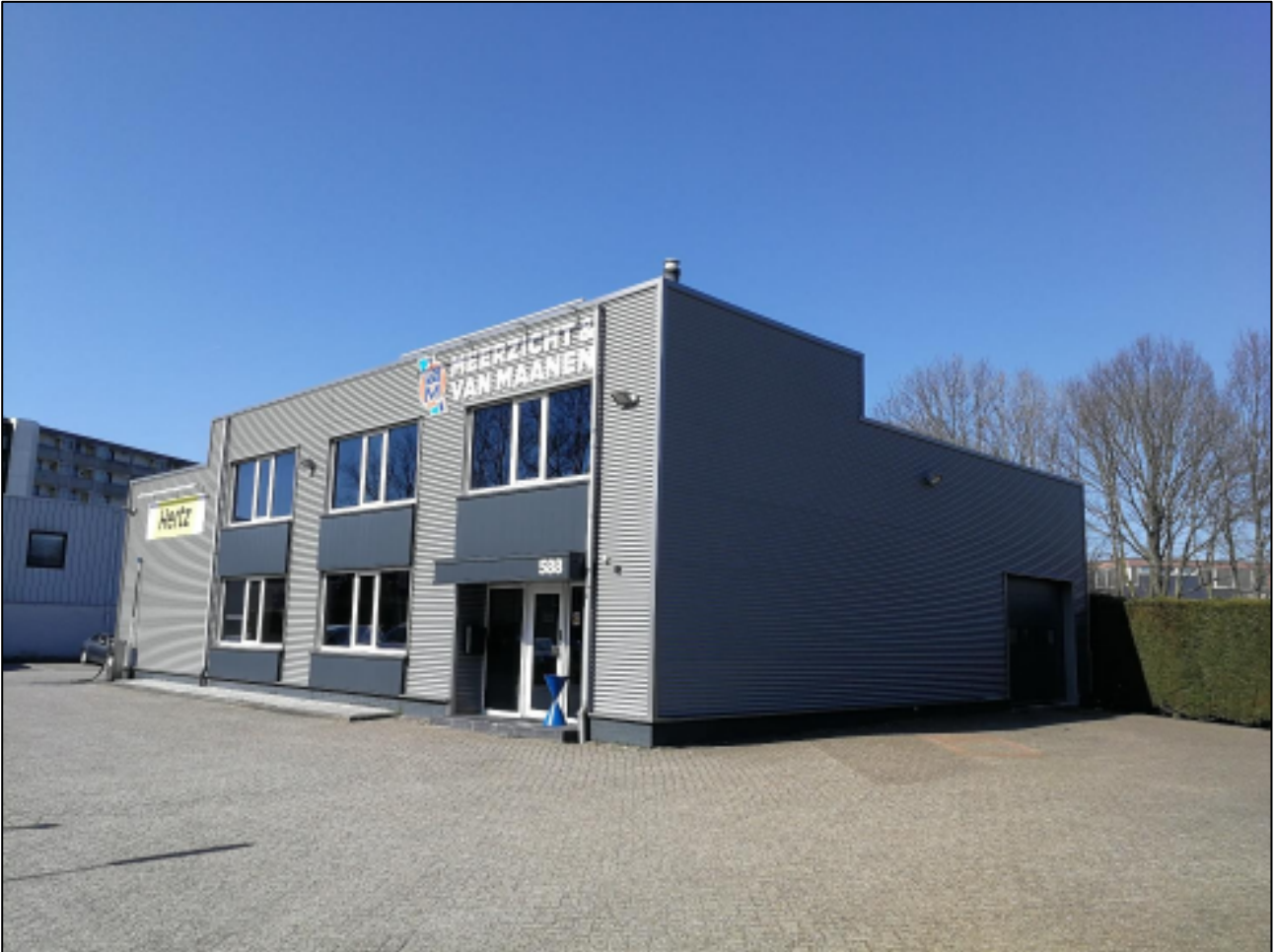
Figuur 2. Zicht op locatie aan de oostzijde, met een van golfplaat opgetrokken bouwwerk zonder noemenswaardige ecologische potenties.
