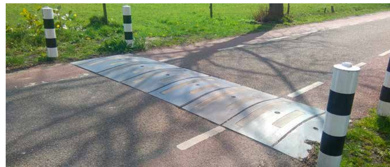
Drempелеlement in asfalt
