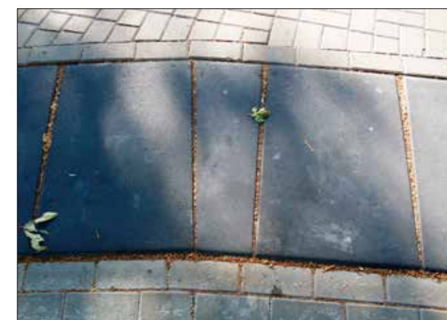
Inritblok 50 x 80 detail zaagstuk in bocht
