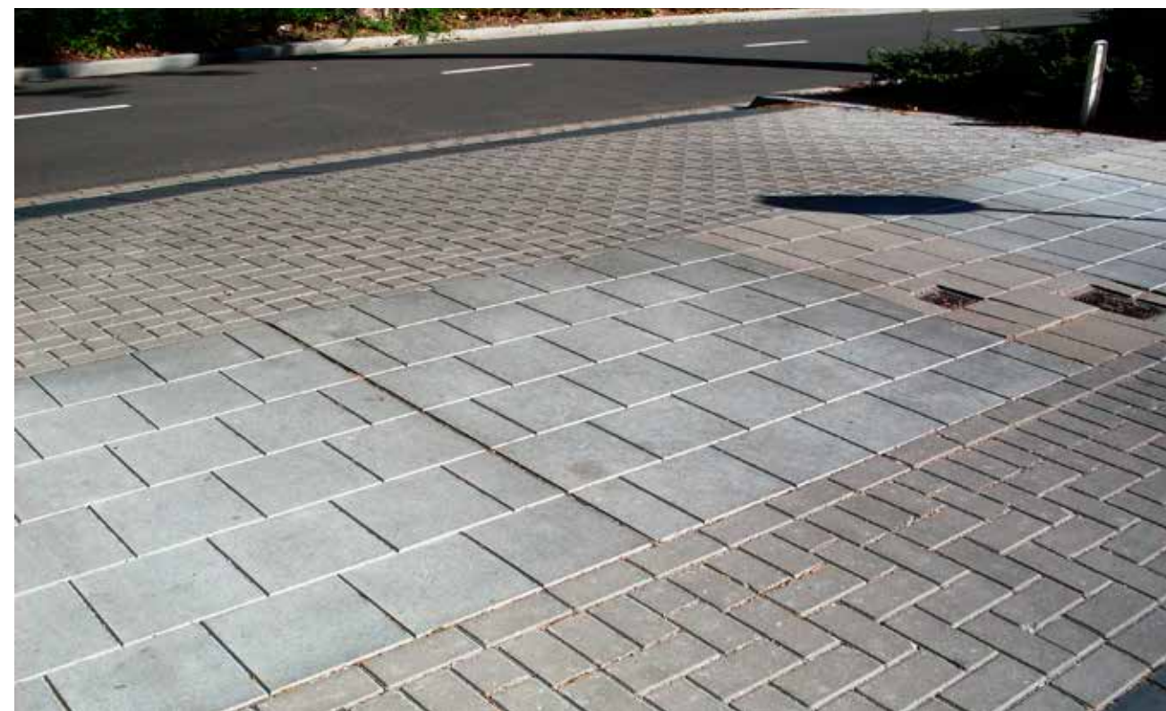
Inritconstructie met klinkers en mammoettegels 180 x 180
