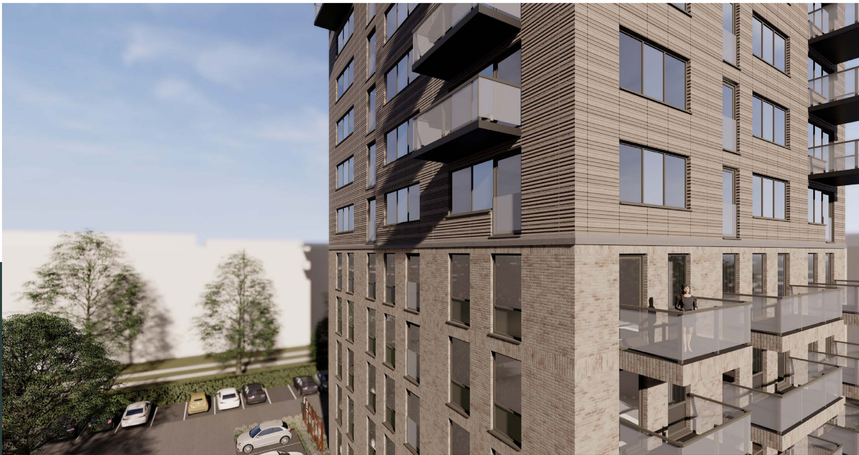
COMBINATIE VAN METSELWERK EN BETON LATTENSTRUCTUUR
