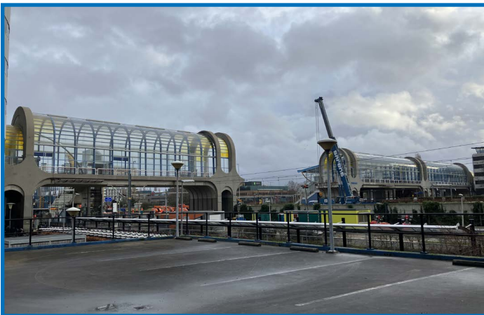
Nelson Mandelabrug december 2022: het brugdeel over de A12 wordt verwijderd.
