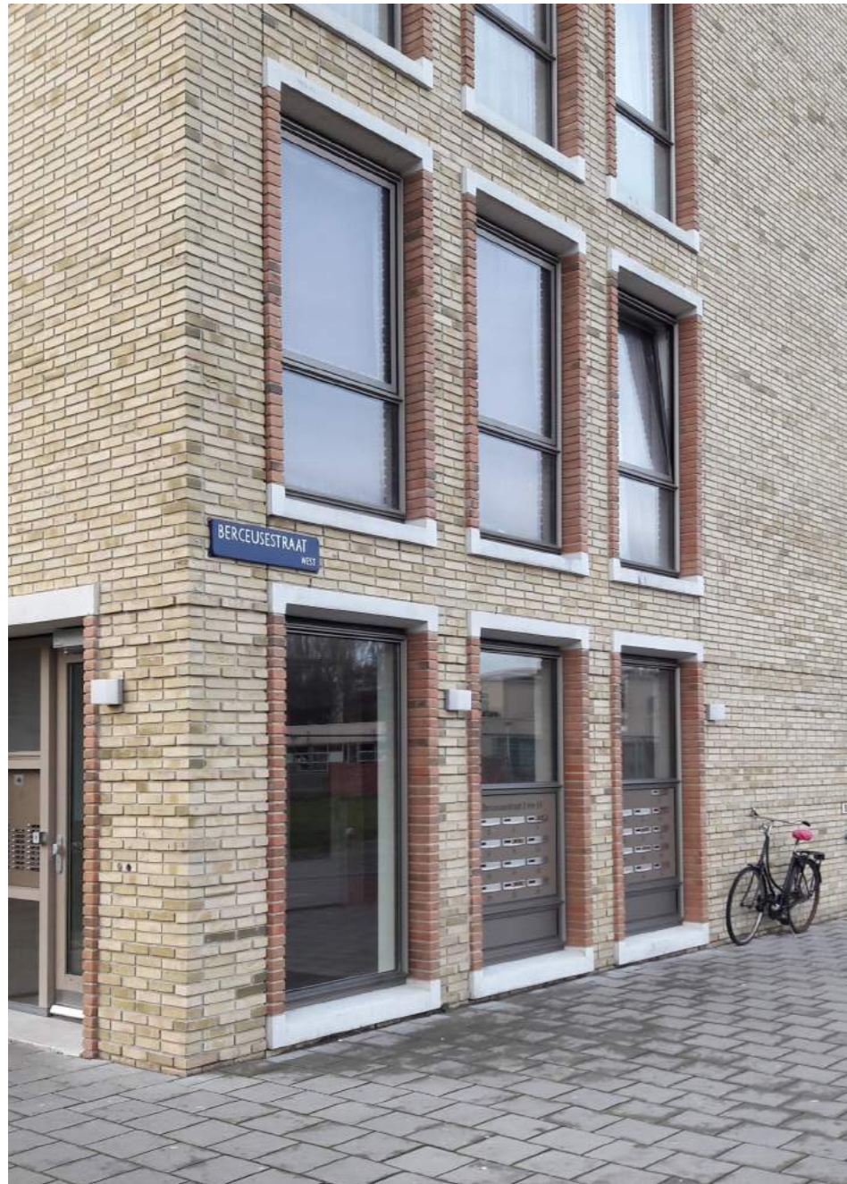
Metselwerk en beton
