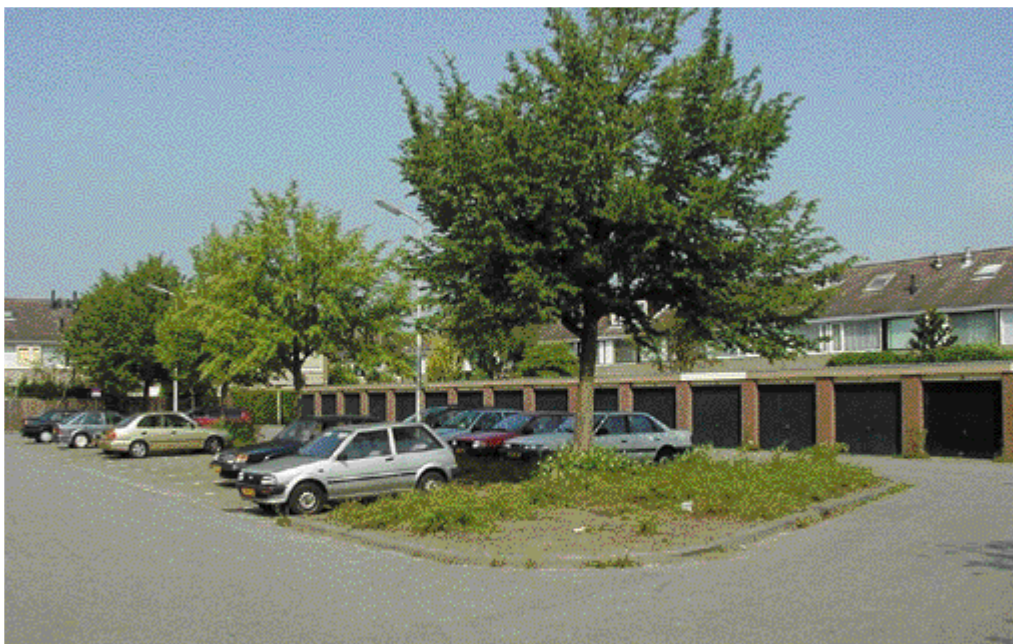
De pleintjes in de Waterbuurt waren gedacht als ontmoetingsplaatsen voor de bewoners, maar de wand van garages en de inrichting als parkeerplaats van bijvoorbeeld het plein aan het Kooienswater nodigen niet uit tot een aangenaam verblijf.
