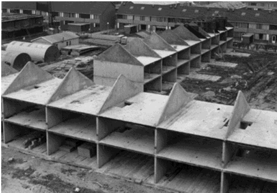
De woningen van de Waterbuurt in aanbouw. Op de voorgrond nog als kaal betonskelet, op de achtergrond zijn ze klaar (1974). Foto Gemeentearchief Zoetermeer.
