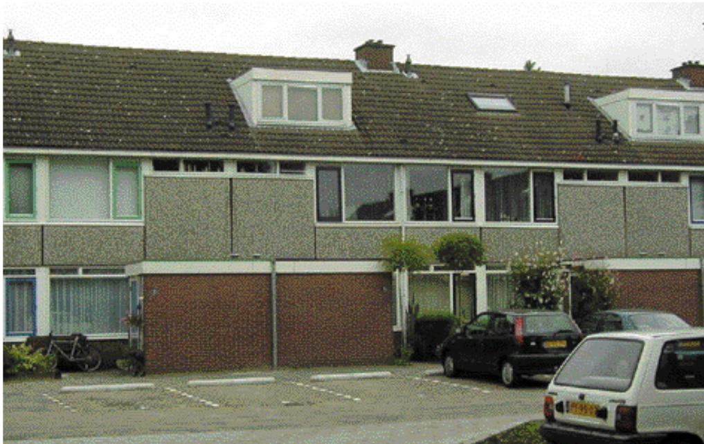
Standaard eengezinswoningen met langskap aan het Opsterland (architect Leo de Jonge). De gevels zijn bedekt met grintplaten.
