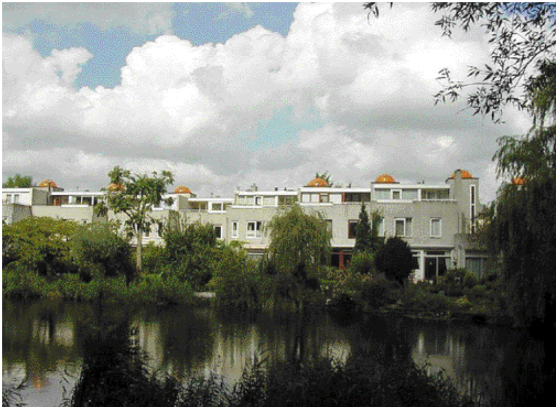
De bekende koepelwoningen van Meerzicht, een bijzonder ontwerp van architect Benno Stegeman uit 1969.
