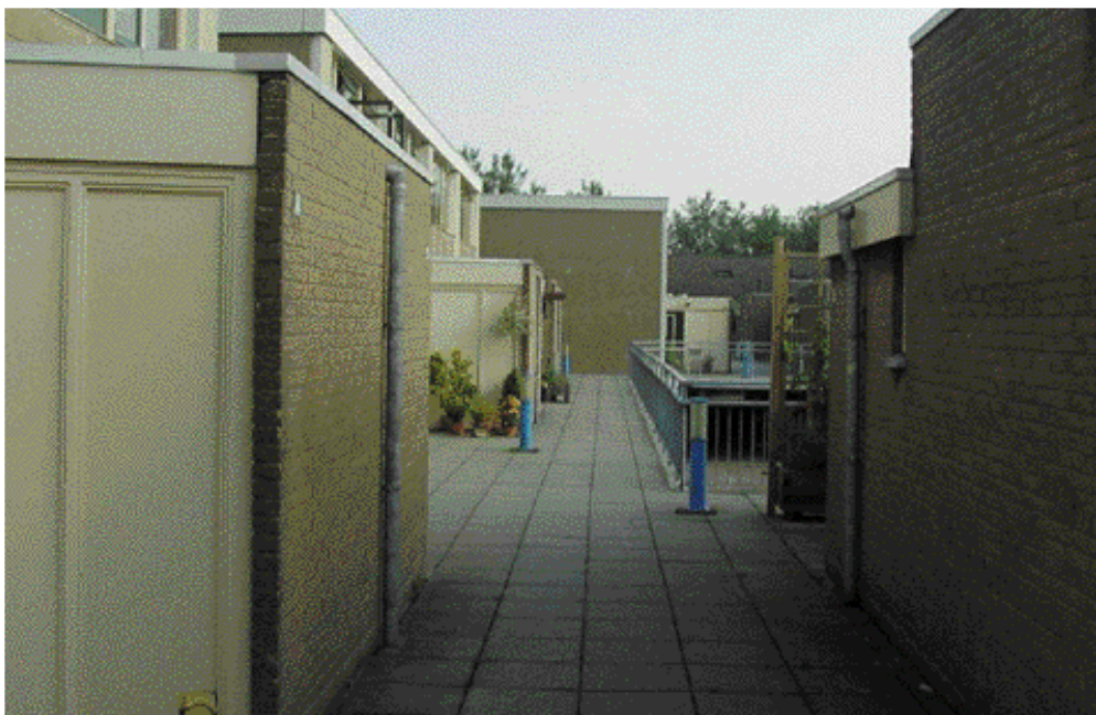
De loopstraat van het woondek aan de Zandberg, waaraan de woningen zijn gelegen. Eronder bevindt zich de rijstraat met de garages en de bergingen.
