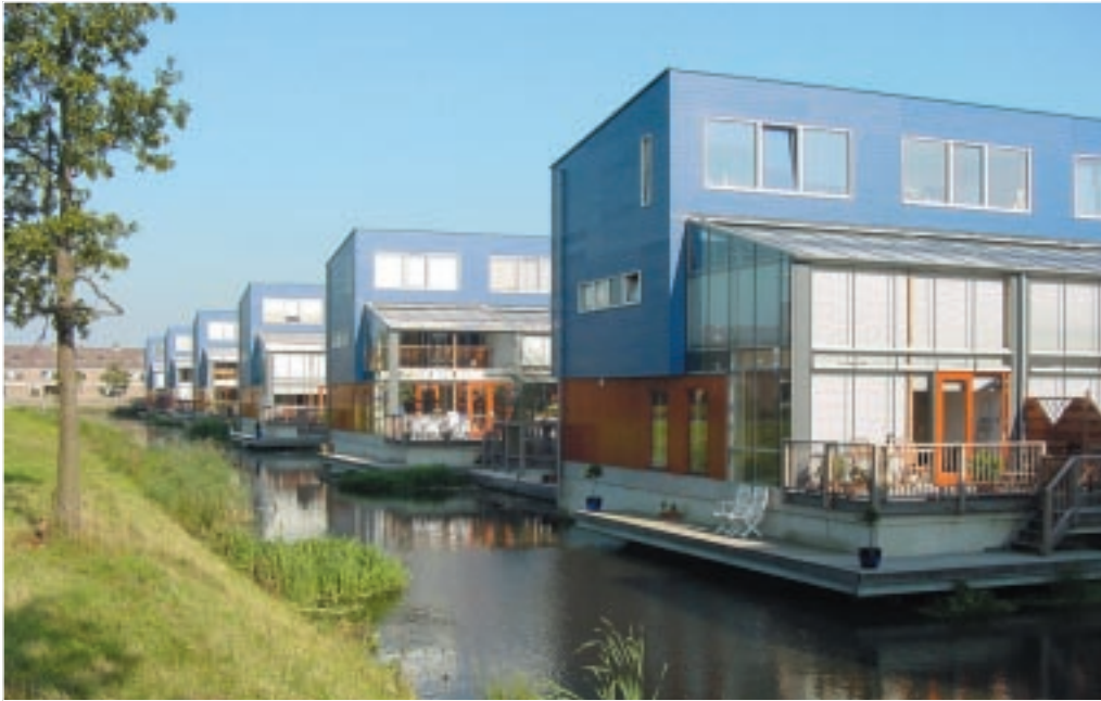
In deze opvallende ecologische architectuur van architectenbureau BEAR aan de Sierappelhof spelen de serres een belangrijke rol in de energiehuishouding. Tevens is hier gebruik gemaakt van duurzame bouwmaterialen.
