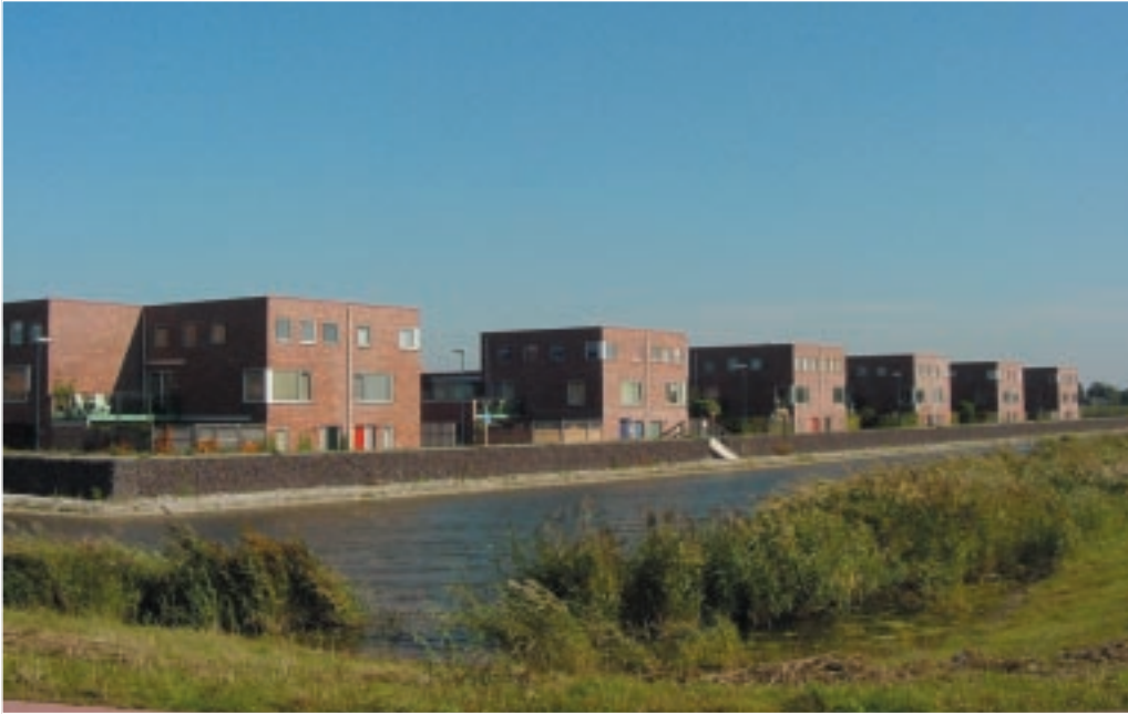
Rond de vesting zijn natuurvriendelijke schanskorven toegepast, waarin allerlei flora zich zal gaan nestelen.
