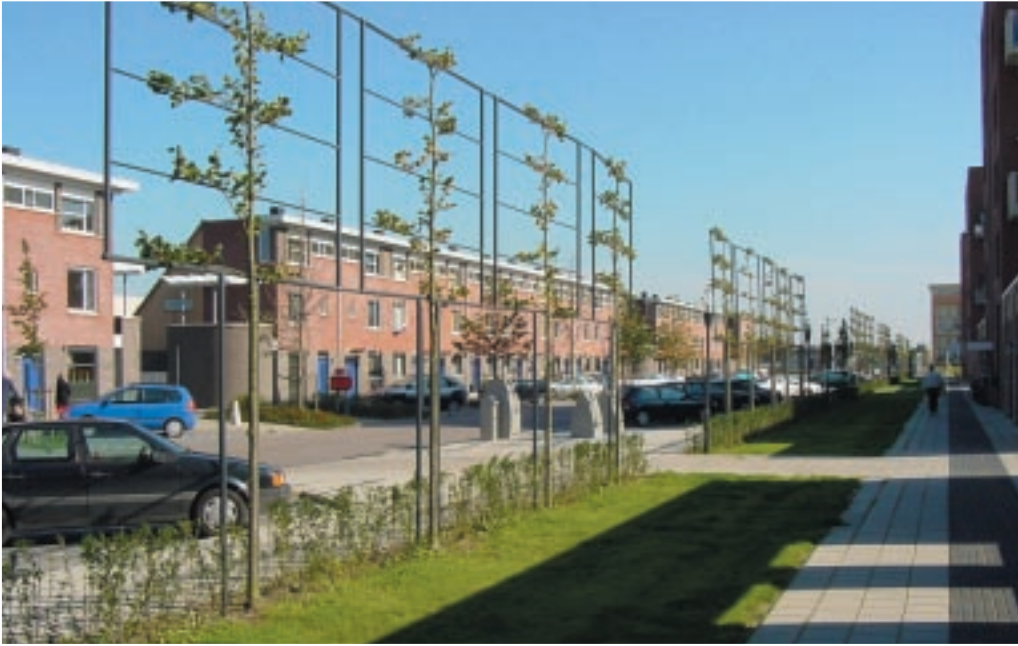
De Dijkmanschans ligt in het verlengde van de voorzieningenstrook en heeft een meer stedelijke allure gekregen met hogere bebouwing.
