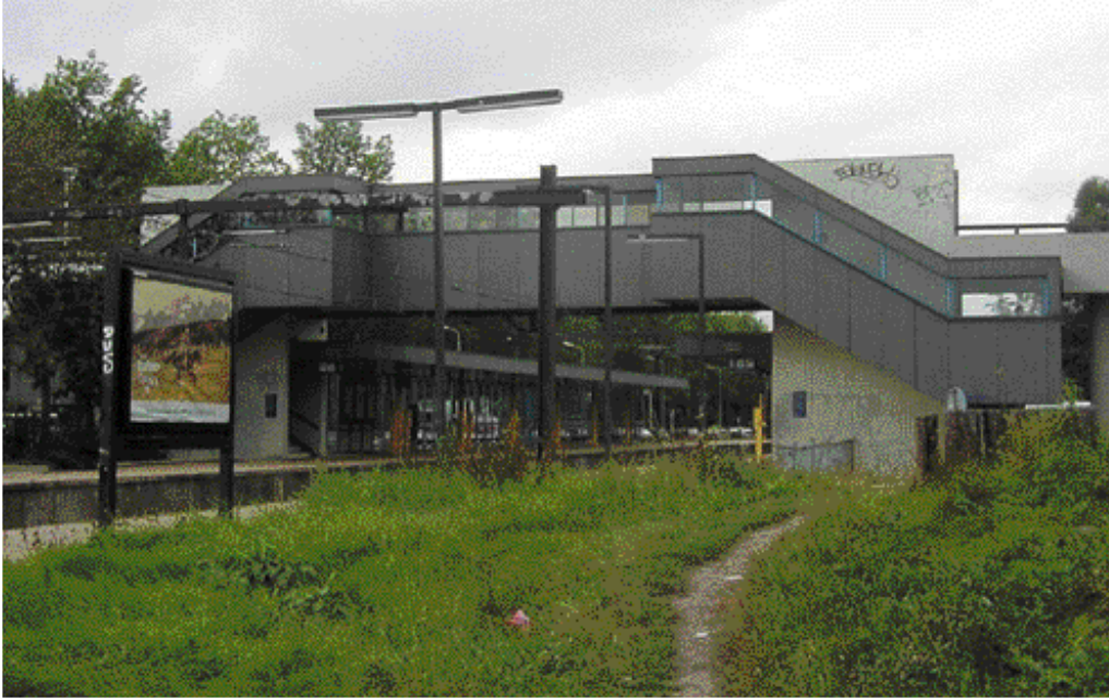
Het sprinterstation Palenstein is door middel van een loopbrug over de Du Meelaan verbonden met het winkelcentrum aan het Croesinckplein.
