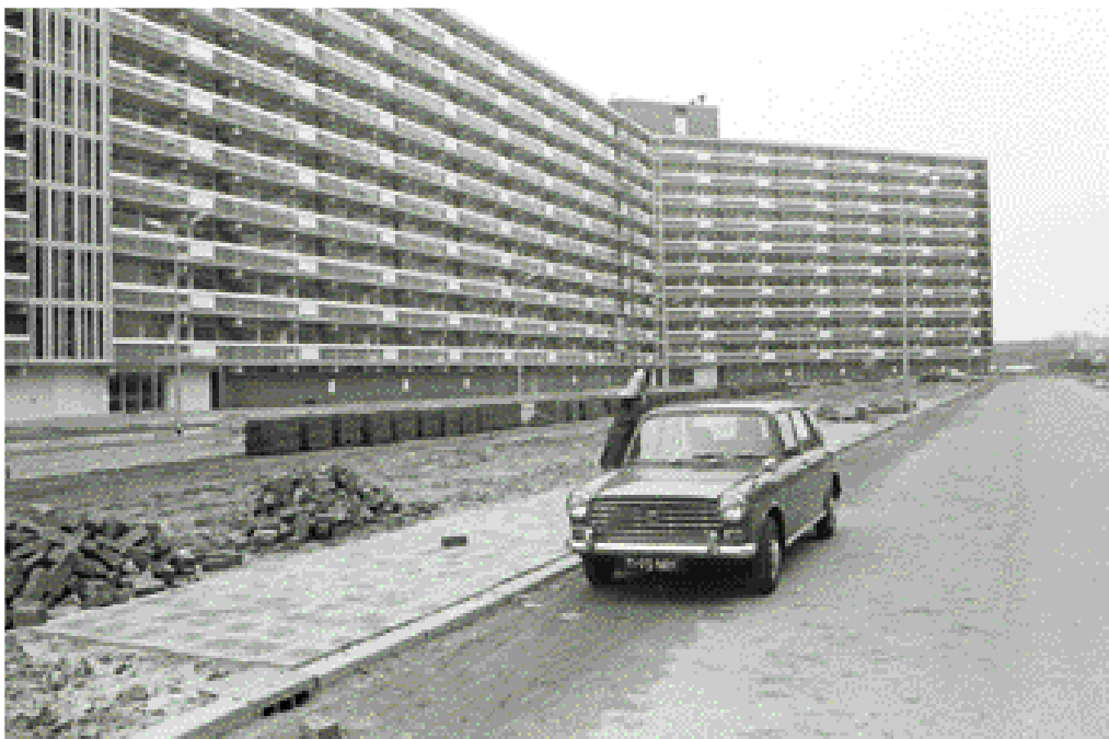
De EBA gebouwen aan de Ambachtsherenlaan (Diederik van Teilingenlaan) in het voorjaar van 1970, vlak voor de oplevering. Hier zijn de oorspronkelijke hekwerken van de galerijen te zien. Foto Wim Coutier.
