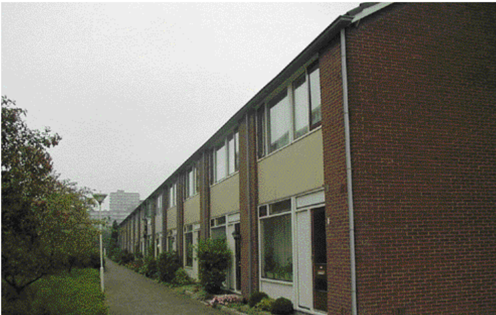
Een gedeelte van de traditionele eengezinswoningen in Palenstein is gebouwd volgens het standaard Fort montagebouwsysteem. Deze woningen staan bekend onder de naam Fort-woningen (Sandrinapad).
