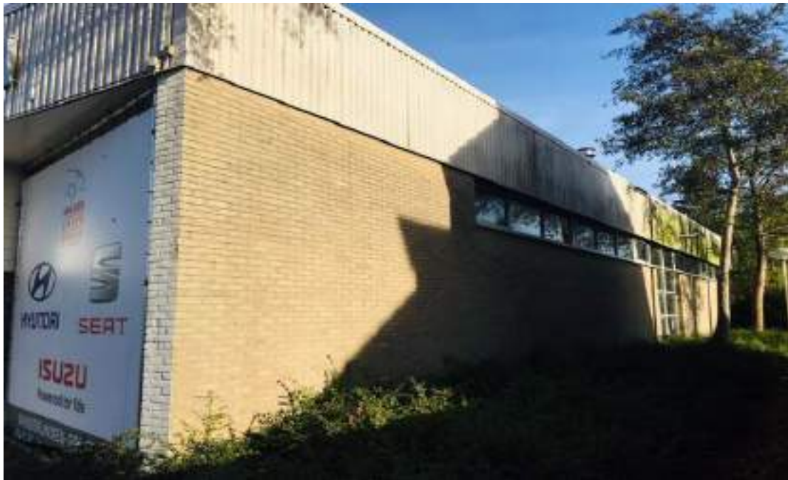
Foto 3. Zijkant van het pand. Er zijn geen stootvoegen of geschikte wegkruipmogelijkheden voor vleermuizen aanwezig (bijvoorbeeld geen spleet tussen het metalen plaatwerk en de stenen muur). Direct rond het pand bevindt zich een strook sierbeplanting (op de foto zichtbaar op de voorgrond) waar algemene soorten amfibieën (als gewone pad) tijdelijk kunnen verblijven (landbiotoop) of waar verblijfplaatsen van algemene soorten zoogdieren (als bosmuis) aanwezig kunnen zijn.
