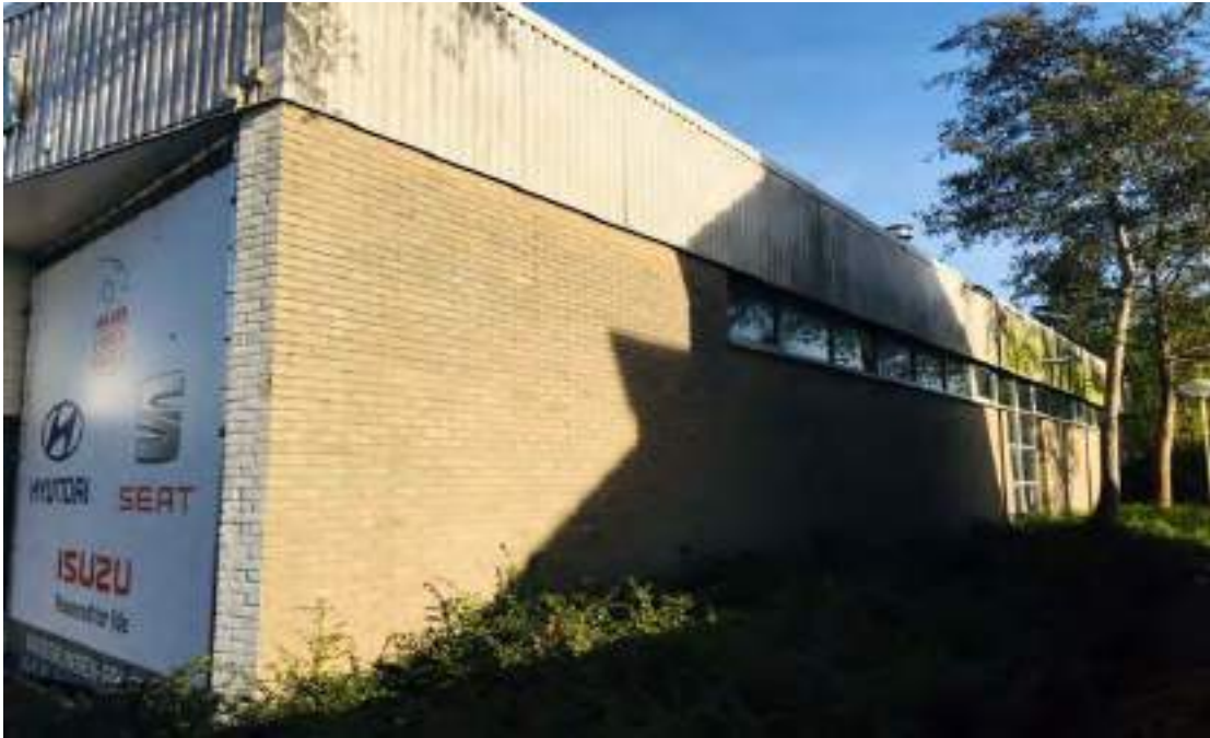
Foto 3. Zijkant van het pand. Er zijn geen stootvoegen of geschikte wegkruipmogelijkheden voor vleermuizen aanwezig (bijvoorbeeld geen spleet tussen het metalen plaatwerk en de stenen muur). Direct rond het pand bevindt zich een strook sierbeplanting (op de foto zichtbaar op de voorgrond) waar algemene soorten amfibieën (als gewone pad) tijdelijk kunnen verblijven (landbiotop) of waar verblijfplaatsen van algemene soorten zoogdieren (als bosmuis) aanwezig kunnen zijn.
