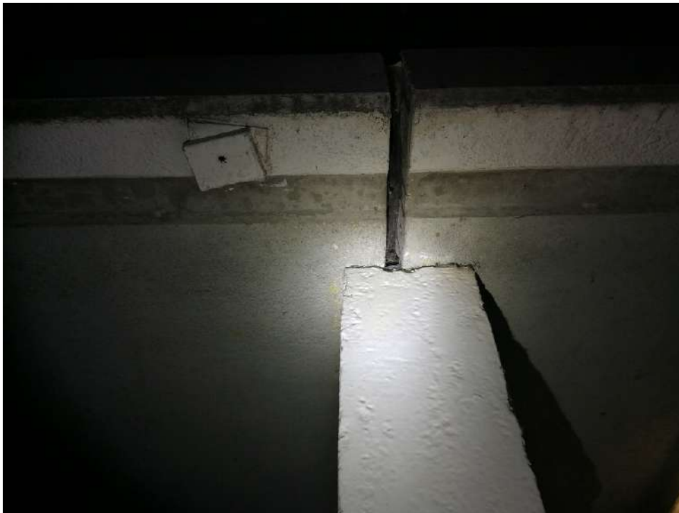
Figuur 6. Voorbeeld van aanwezige spleetvormige ruimten tussen twee betonvloeren: gebruikt door Gewone en Ruige dwergvleermuis.
