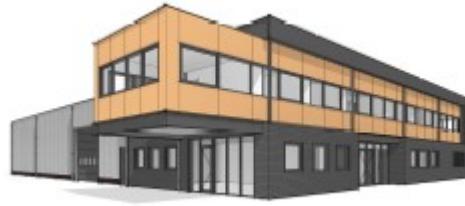
Bestaande gevel Bron: BFM beheer B.V. en PALAZZO OOST bv
