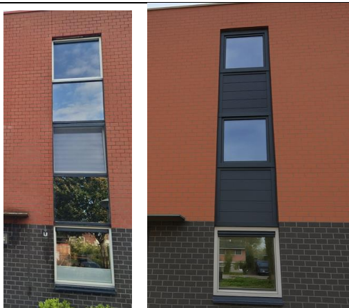
Voorgevel bestaand en nieuw Bron: aanvraagdossier
