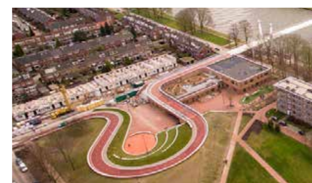
Fietsroute over het dak van een schoolgebouw, Utrecht
