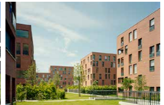
Rugacherm - Baumschlager Eberle Architekten
