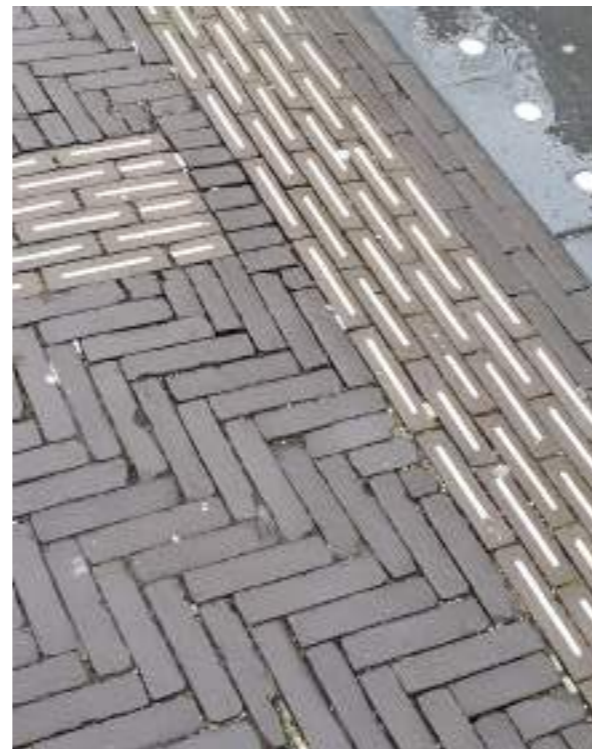
Daar waar de gevel niet als gidslijn gebruikt kan worden komt er een subtiele markering als verbindend element tussen de geveldelen.
