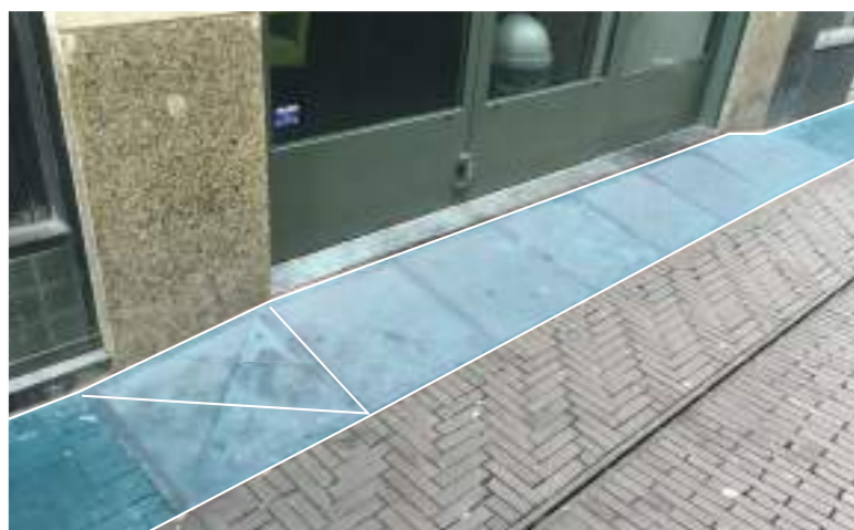
Fotobewerking oplossing voor hoogteverschil bestrating-dorpel, met in wit kniklijnen
