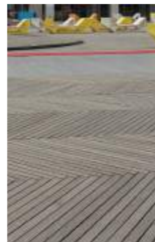
Plein als meubelstuk van het winkelhart. De vloer van hoogwaardig beton refereert naar een plankenpatroon van een houten vloer. het horizontale plein krijgt een hoogteverschil door aflopende straten waardoor een zitrand ontstaat.
