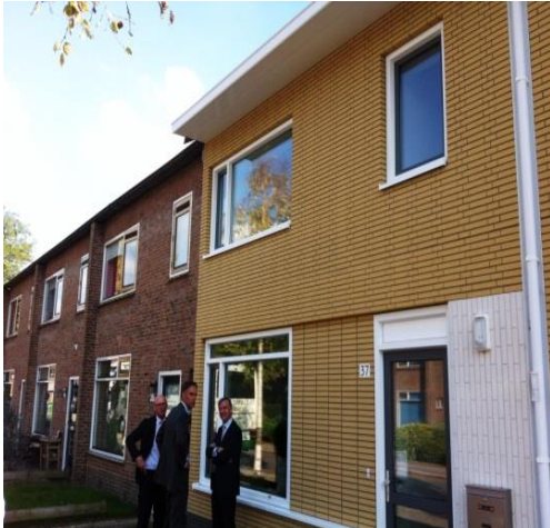
Nul op de Meter renovatie in Soesterberg
