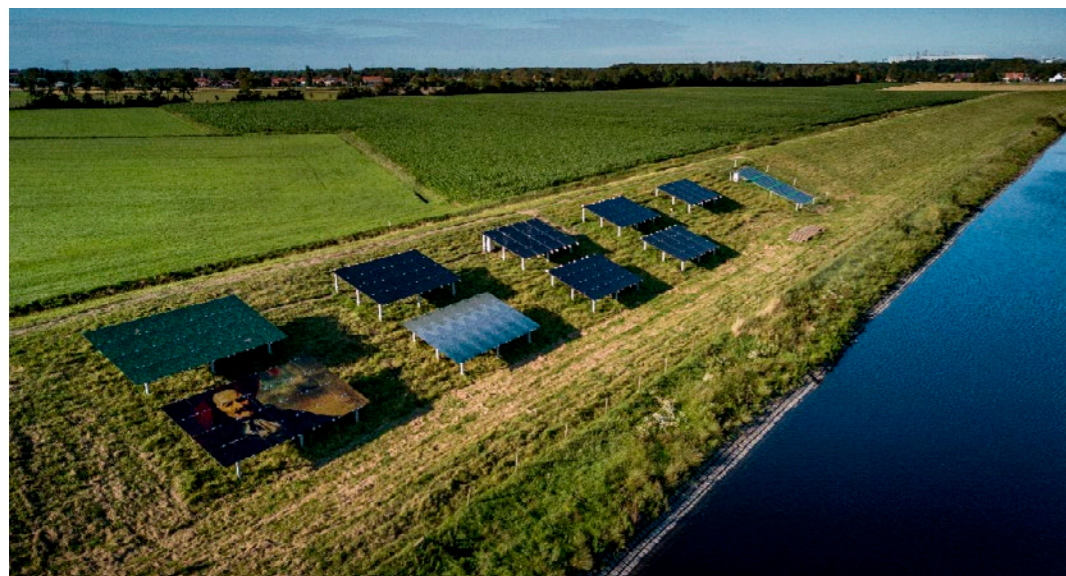
Voorbeeld van zonnepanelen op dijken (pilot Rithem)
