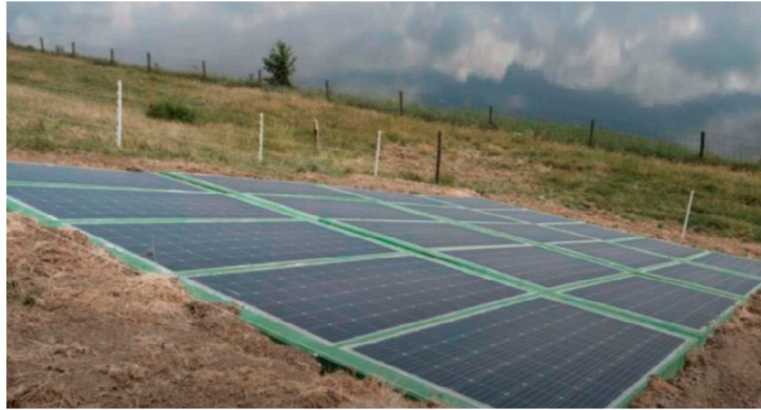
Voorbeeld van zonnepanelen als dijkbekleding
