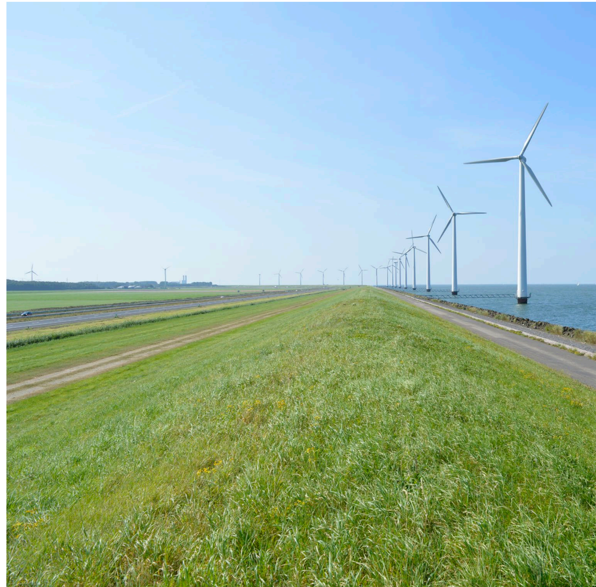
Beeld van bestaande IJsselmeerdijk kijkend richting Lelystad met de A6 en de huidige karakteristieke rij windturbines ter weerszijde
