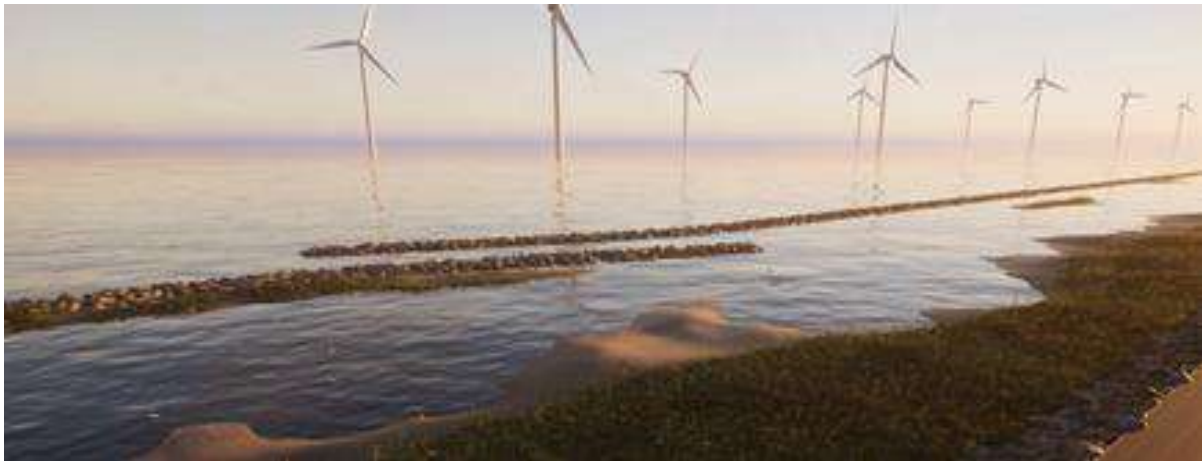
Figuur 2-2: Impressie van de vooroever (beperkte ecologische inrichting) met verspringende langsdammen bij openingen
