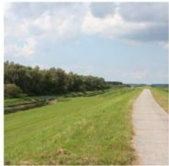
Bossen aan de voet van de dijk
