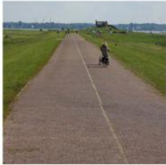
Klinkerweg op de dijk
