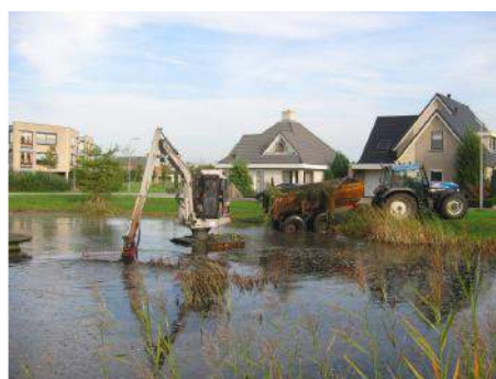
Afbeelding 6.1 Onderhoud van stedelijk water is soms een heikel karwei door beperkte bereikbaarheid
