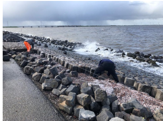
Figuur 8 Herzetten steenbekleding Zuidermeerdijk
