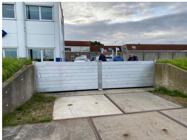
Figuur 9 Proefsluiting coupure Lelystad
