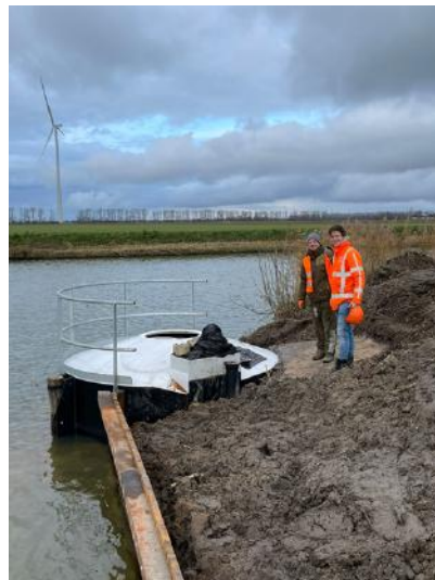
Figuur 20: aanleg vispassage Oldebroekertocht
