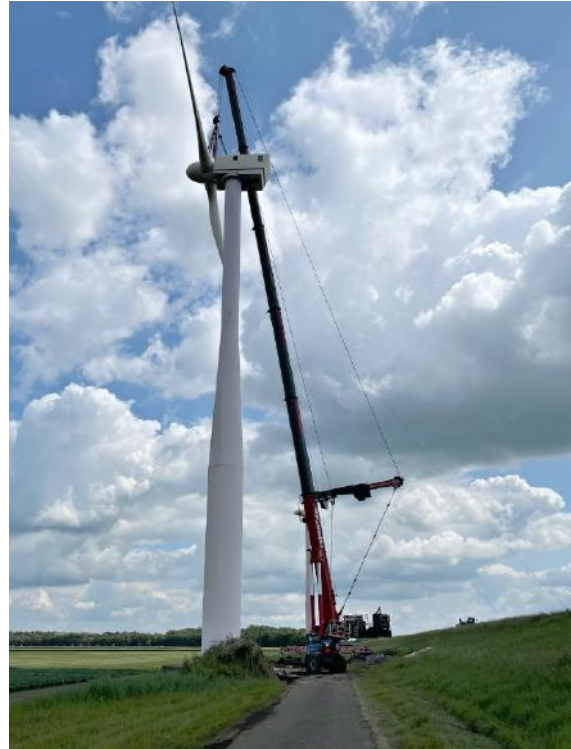
Figuur 10 Verwijderen van de windmolens aan de Eemmeerdijk
