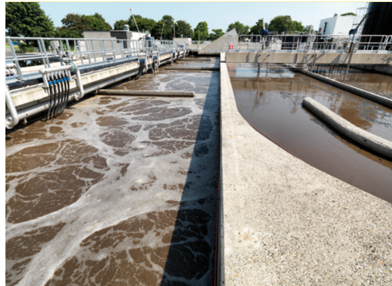
Op onder andere AWZI Dronten produceren we brandstoffen en energie uit het afvalwater
