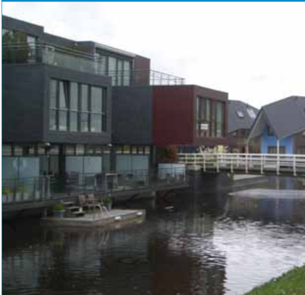
DOORLOPENDE STEIGER EN PONTON
