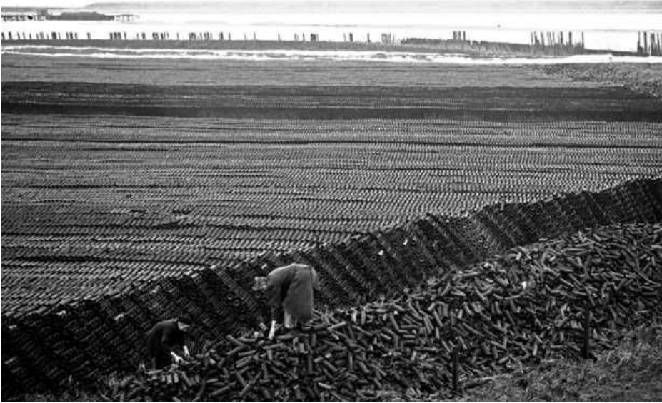
VOLLENHOVE 1940 -De Zuiderzeewerken, Noordoostpolder. Ongeveer 10 miljoen draineerbuizen liggen gereed om bij de drooglegging van de Noordoostpolder te worden gebruikt. ANPFOTO/BEDIJS
