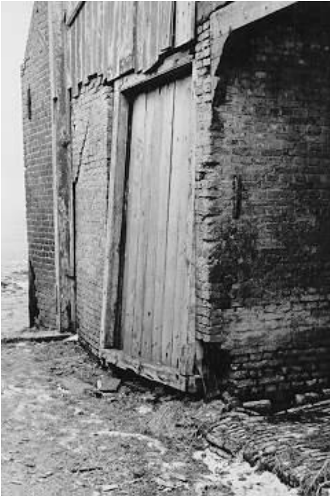
Schade aan een boerderij in Overijssel (1953).
