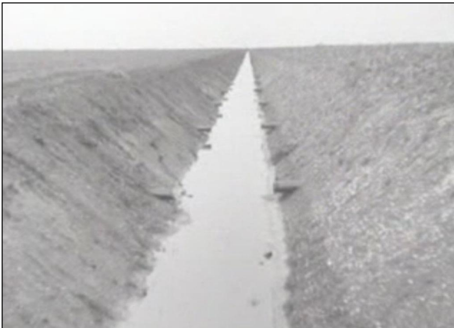
Drainagebuizen uitmondend in een kavelsloot.
