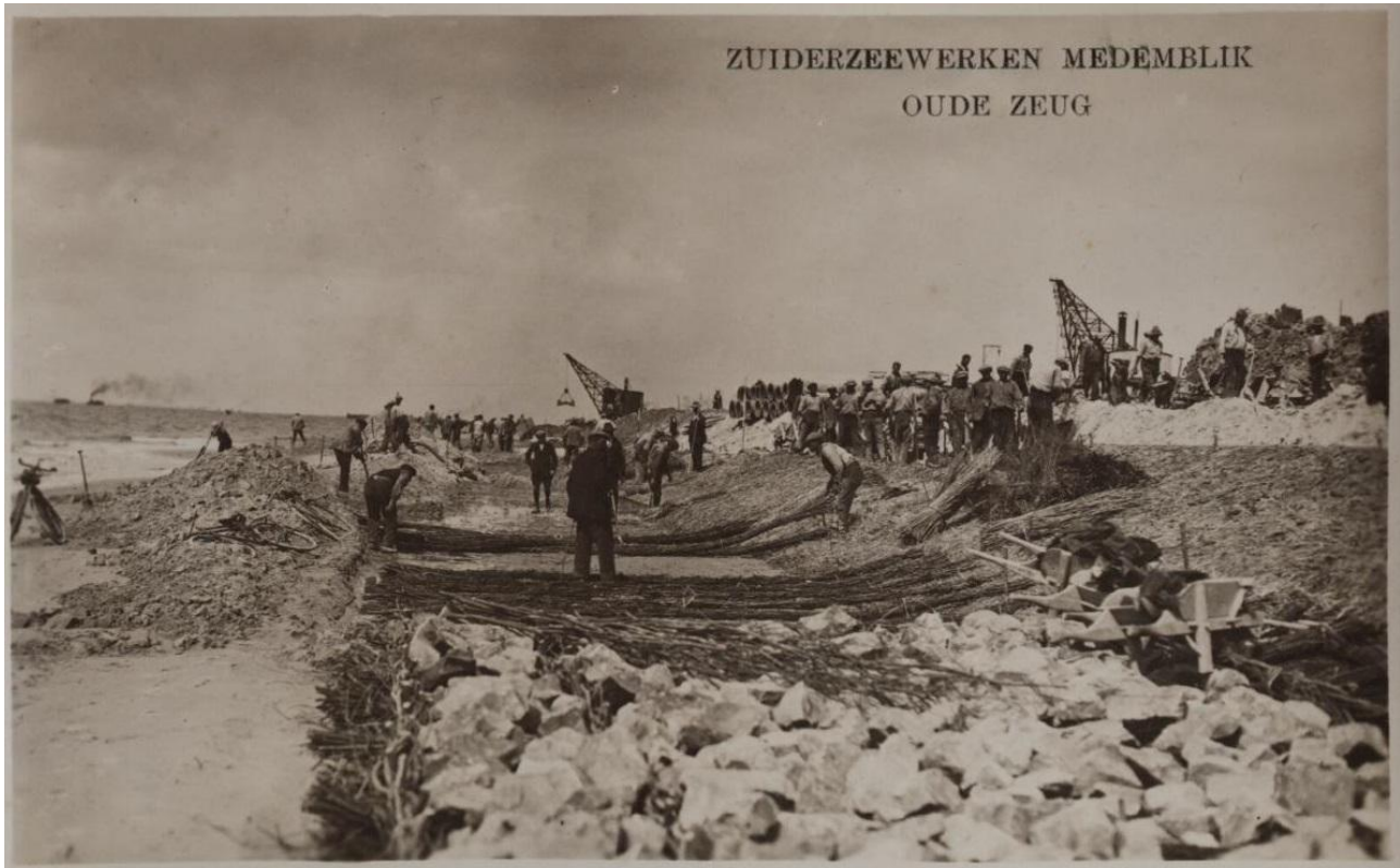
Aanleggen van een dijk met rijshouten matten en steen bij Medemblik in 1928.
