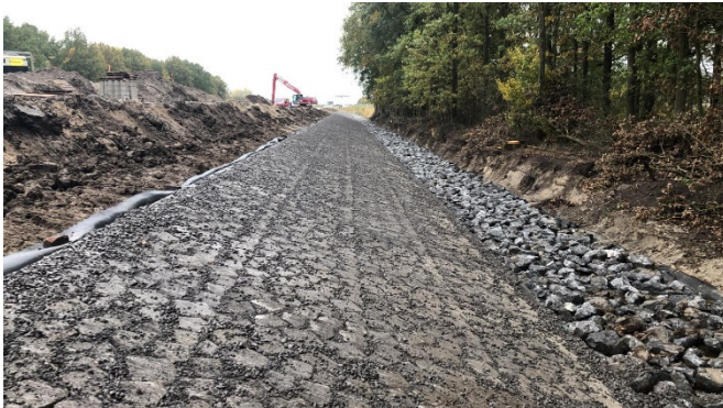
Nieuwe steenbekleding dijkversterking Drontermeerdijk 2020
