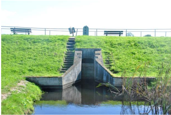
Inlaat Repelweg Repelweg/kavel S51/S33 ZZLINL-ZZL-07
