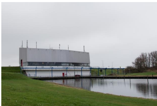
Gemaal De Blocq van Kuffeler
