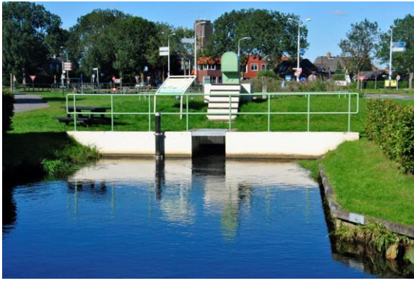
Inlaat Kuinre Hopweg/KuinderwegZZL INL-ZZL-04
