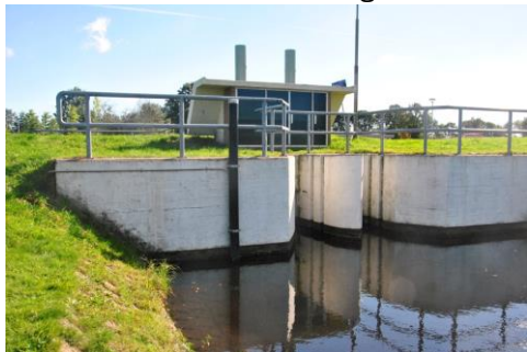
Inlaat Blokzijl /Vollehoverkanaal ZZL INL-ZZL-05
