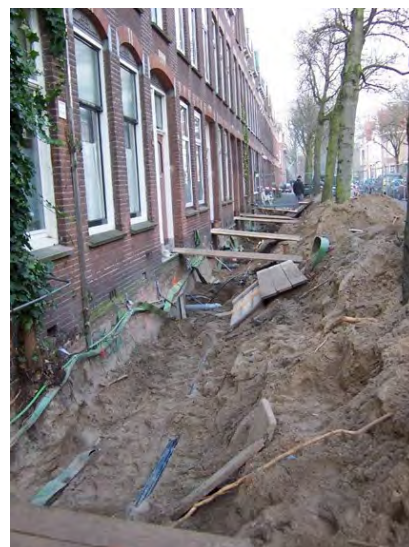
Figuur 6: Werk aan kabels en leidingen.
