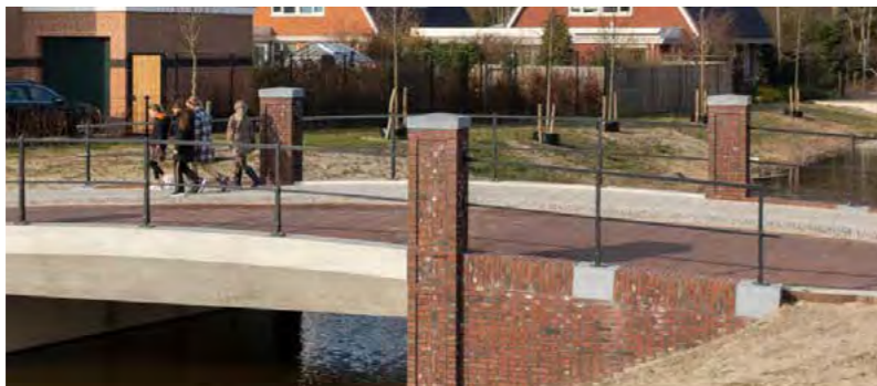
Straatwerk loopt door over de brug
