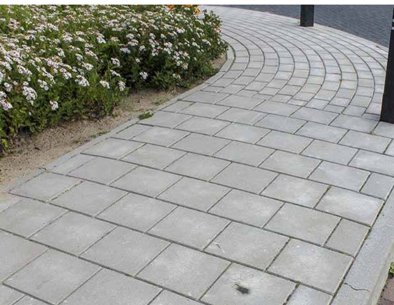
Materialisering woonpad (betontegels, grijs, halfsteensverband)
