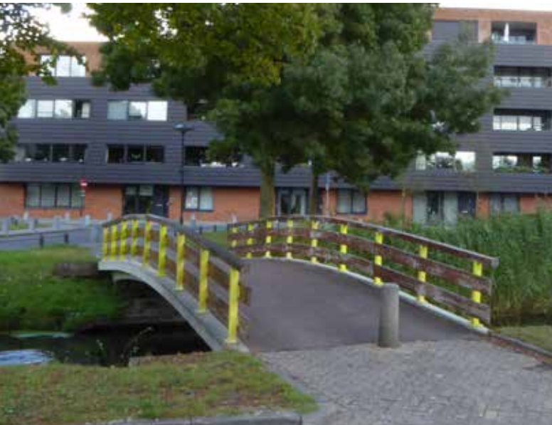
Bestaande brug Stampioenstraat behouden
