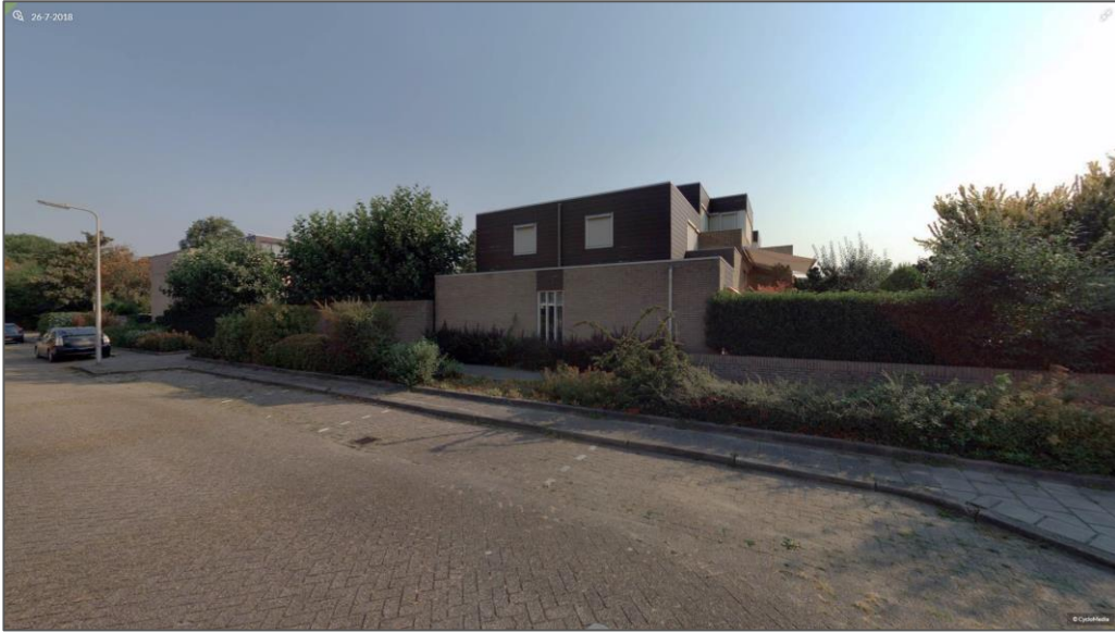
Figuur B.4 – Sectie 14, Zeemanstraat (zuidelijk deel): parkeerhaven met 5 parkeerplaatsen (bron: Cyclomedia Streetsmart, situatie d.d. 26-7-2018)
