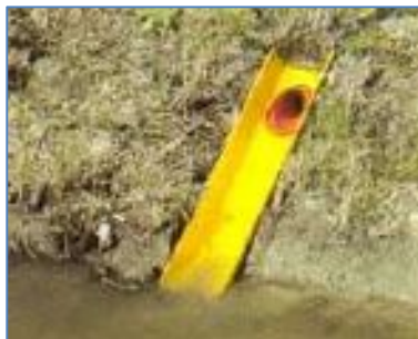
Figuur 2: Kunststof taludgoot t.p.v. uitstroom drainage
