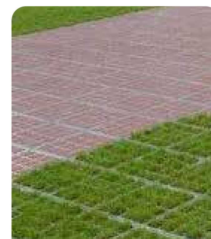
Open bestrating voor het bergen van hemelwater en fraai beeld
