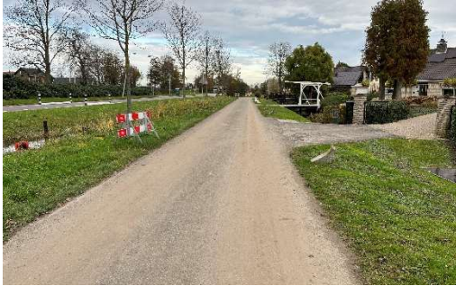
Figuur 3.1: Inrichting parallelweg met aan de rechterkant de uitritten van de aanwezige woningen 5 .
