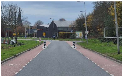
Figuur 3.4: Inrichting Swanlaweg met fietsstroken en een tweezijdige wegversmalling.
