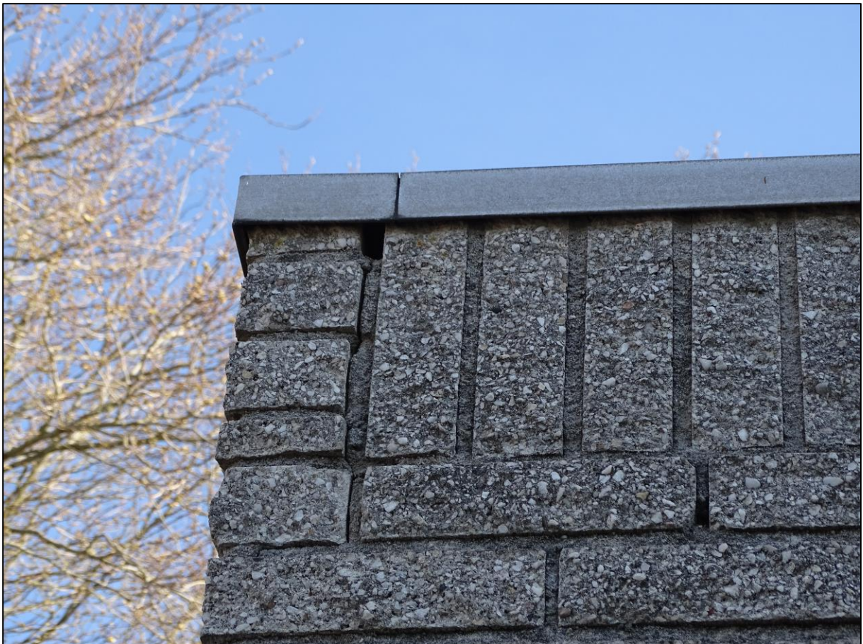
Figuur 4.4 In de gevels van het schoolgebouw zijn verschillende openingen aanwezig.
